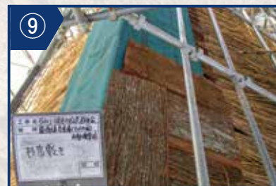
⑨棟に防水シートを敷き、杉皮を張ります。
