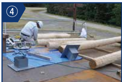
④クリ材を加工し、新たな柱をつくります。
