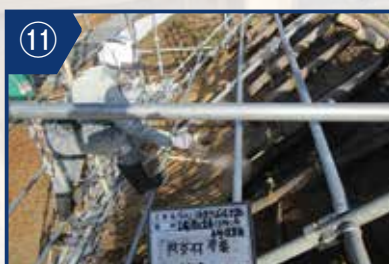
⑪防火剤を全体に散布します。
