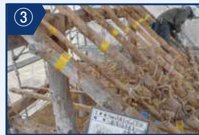
③垂木 たるぎ ・小舞 こまい などの部材に記号を付けた上で解体します。
