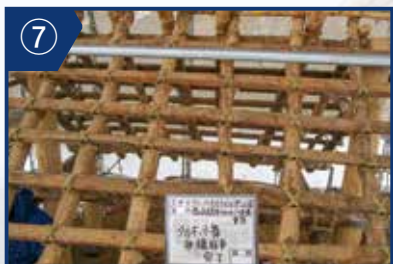
⑦解体時に付けた記号を元に屋根下地を組み立てます。
