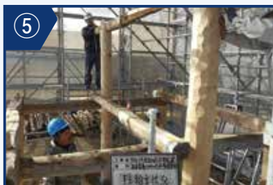
⑤新しい柱を立て、骨格を組み立てます。
