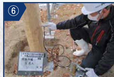
⑥長寿命化のため、シロアリ防止剤を注入したり防腐剤を塗布します。
