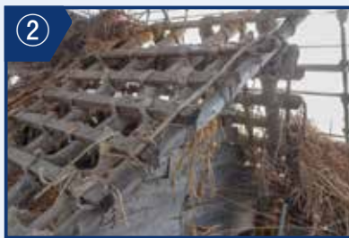
②屋根の茅等 かや を撤去します。
